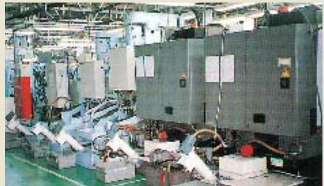
●セパレーター (既存タンクへの据え付け)
