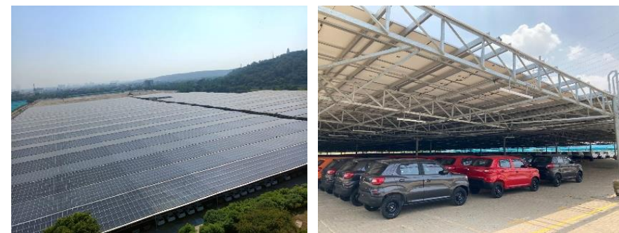
マネサール工場のモータープールの頭上に設置したソーラーパネル
