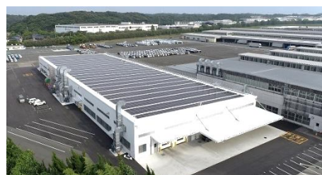
⑤湖西第一東 新完成検査棟
