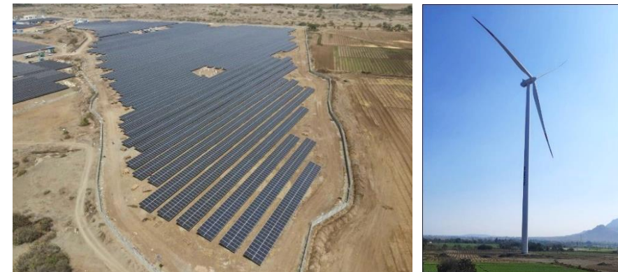
SMG向けの発電施設（ReNew社提供）
