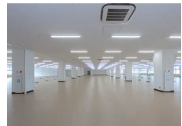
LED照明の導入
