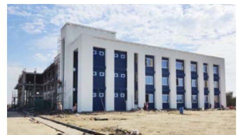
グジャラート州シタプールに建設中の学校
